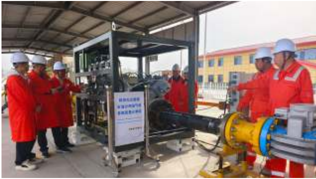
图为：某高含硫项目非放湿气流量计成功通过国内天然气计量站沈阳分站的性能测试认证
