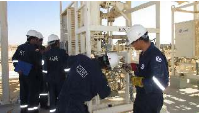
多相流量计现场安装调试
