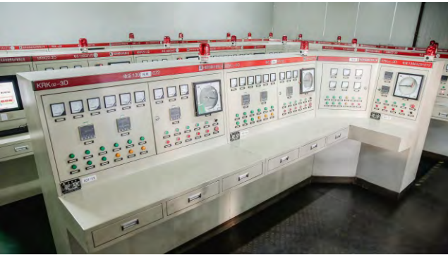
热处理控制室
